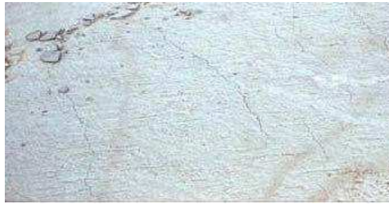
Εικόνα 1 - Ρηγμάτωση σκυροδέματος σε πλαστική κατάσταση
