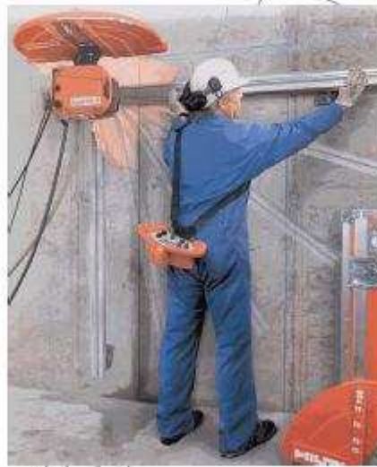
Σχήμα 2 - Κοπή τοίχου με δισκοπρίοιο επί τροχιών καθοδήγησης
