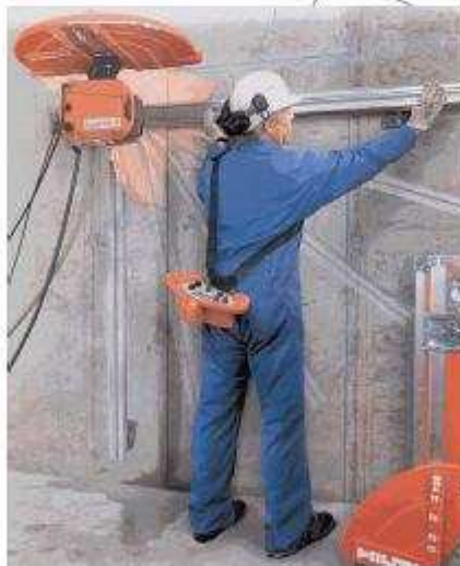
Σχήμα 2 - Κοπή τοίχου με δισκοπρίοιο επί τροχιών καθοδήγησης
