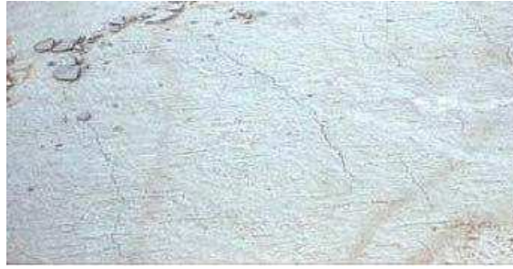
Εικόνα 1 - Ρηγμάτωση σκυροδέματος σε πλαστική κατάσταση
